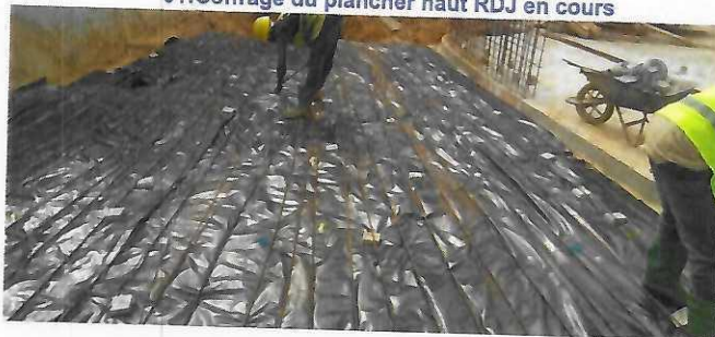
01:Coffrage du plancher haut RDJ en cours
